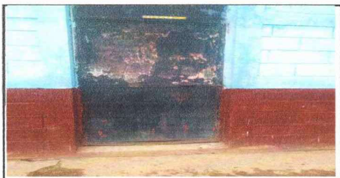
FOTO 6: SUSTITUCION DE PUERTAS DE LA ESCUELA
