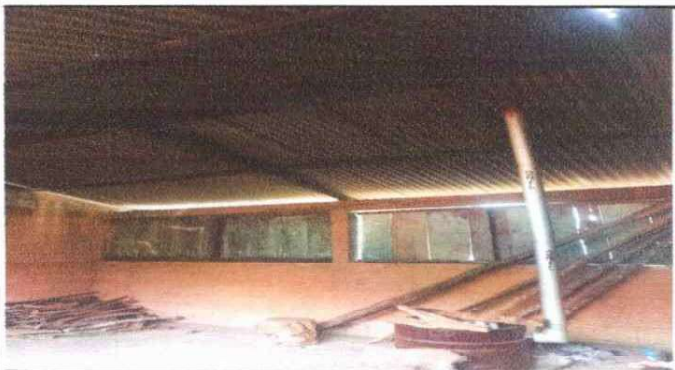
FOTO 3: SUSTITUCION DE TECHO DE COCINA
