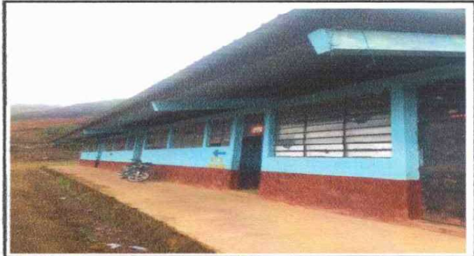
FOTO 2: SUSTITUCION DE CANALES Y BAJADAS DE AGUA PLUVIAL
